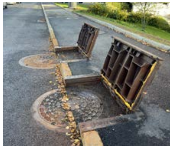
Til venstre: eksempel på en av flere gamle løsninger i Oslo kommune. Til høyre: ny løsning fra Furnes, kantstenslokk. Forrige side: Åsmund Svedjan, byggeleder i Oslo VAV.
