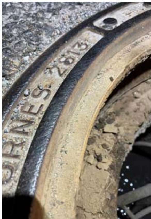
Ramen är i gott skick och visar inga tecken på betydande påverkan efter drift under dessa förhållanden
